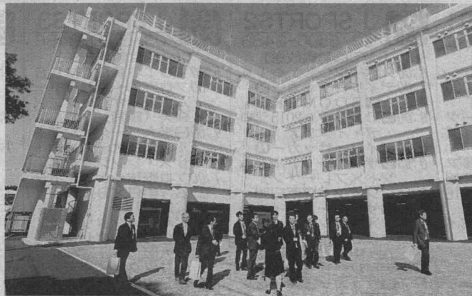
完成した新病棟。津波対策のため1階部分は柱のみの構造となっている
